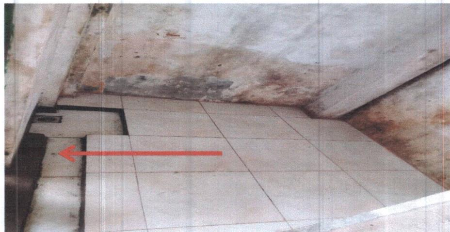
Bangunan TPS limbah B3 dilengkapi dengan sistem drenase yang berada pada pinggir bangunan.
